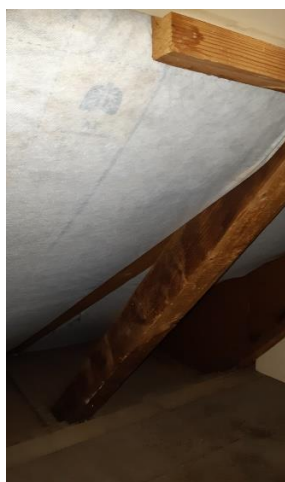
Dämmung im Satteldach
